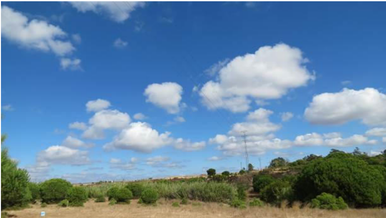
Línea aérea de media tensión a modificar, a su paso por la parcela de la nueva subestación.
