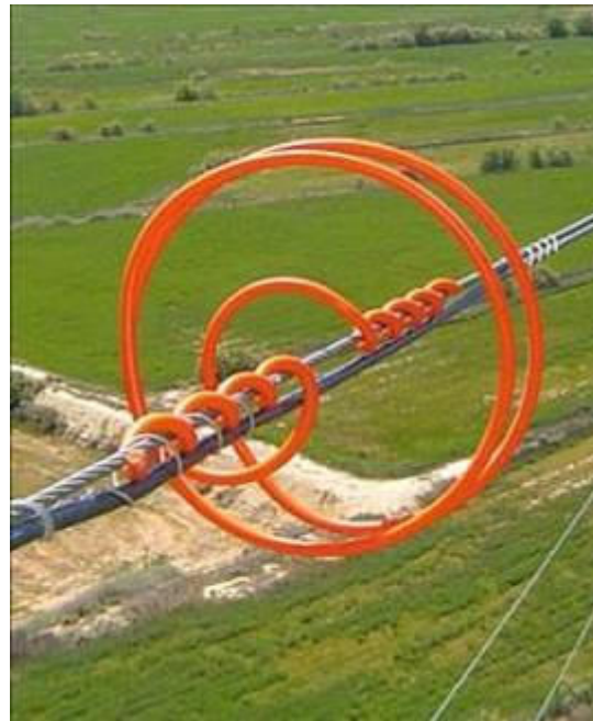
Dispositivo anticolidión en espiral
