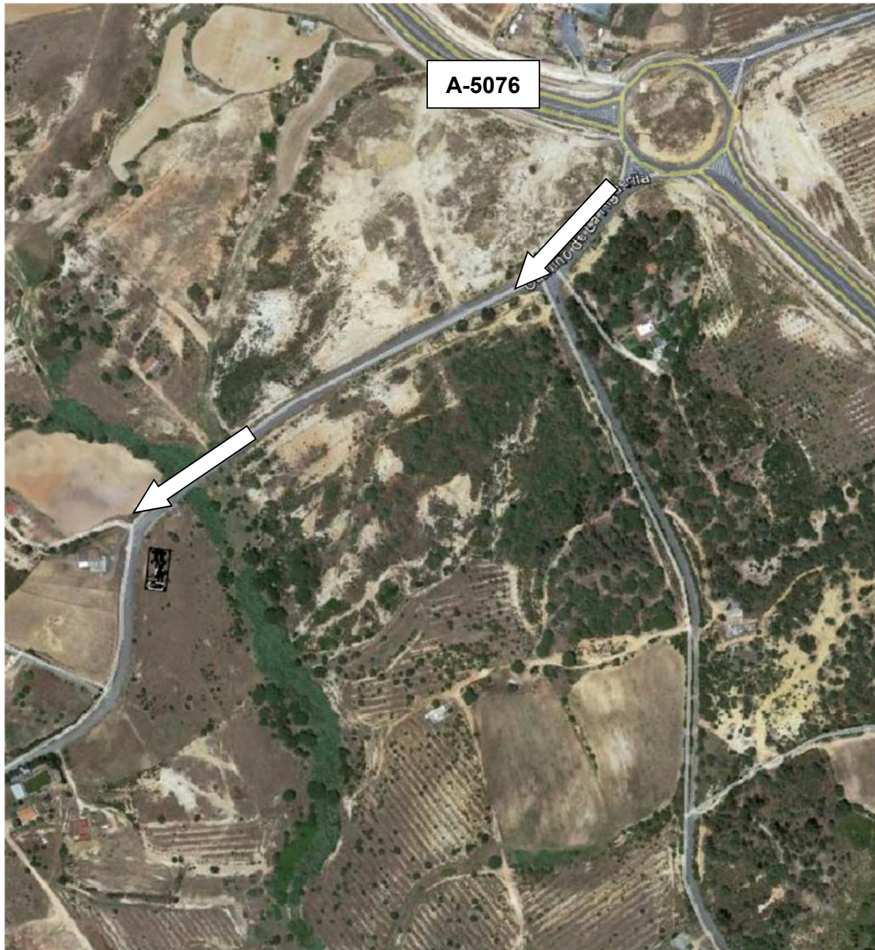
Acceso a las Subestación Eléctrica
